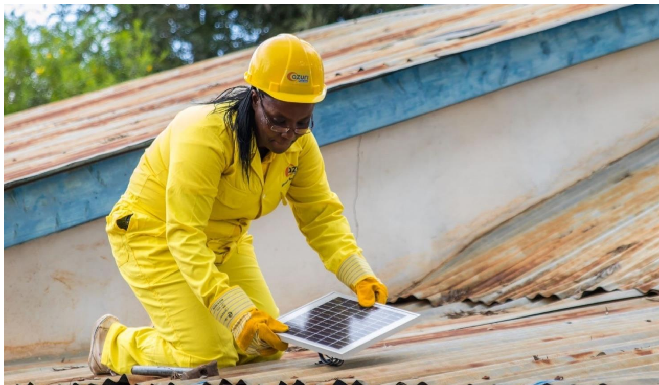
写真:屋根上にソーラーパネルを設置する Azuri のエンジニア
