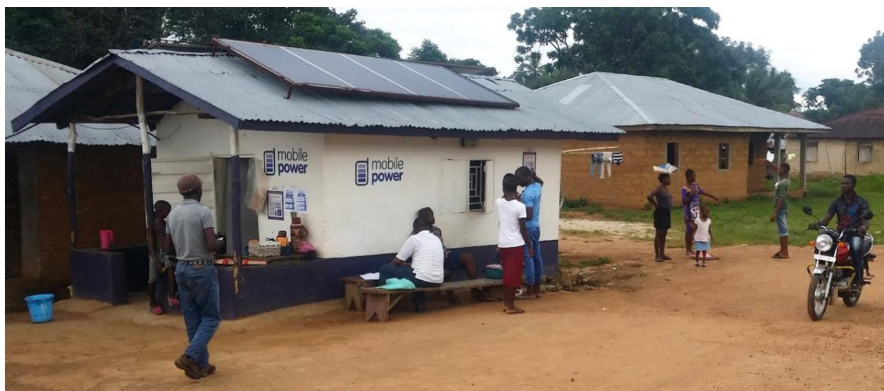
写真: 電池パック充電用の Mobile Power ハブは、地域コミュニティの中心としても機能している。
